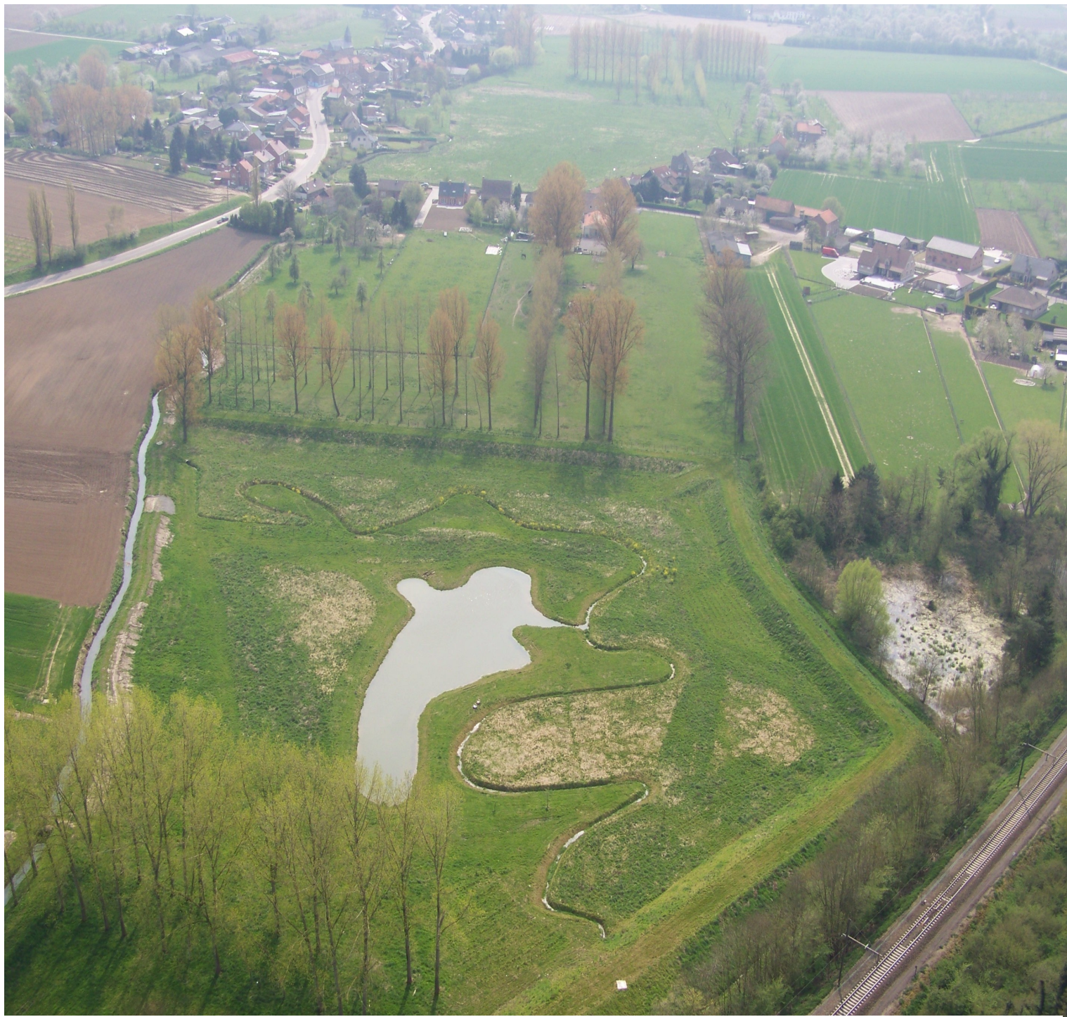
Gecontroleerde overstroomingszone te Stayen (Sint-Truiden) in droge periode
