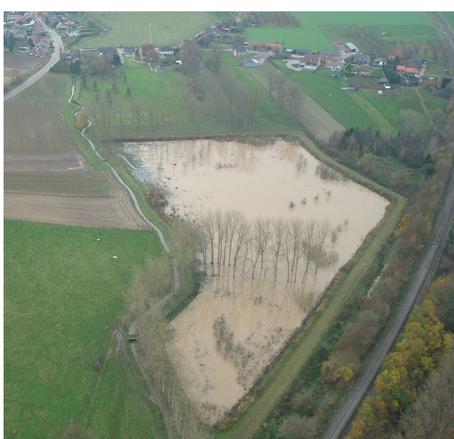
Gecontroleerde overstromingszone te Stayen (Sint-Truiden) in werking
